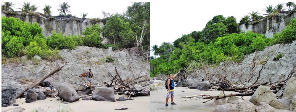
Figura 2 – Grande escorregamento em Praia da Paixão. (a) À esquerda, visão frontal explicitando a cunha de detritos erguida durante o escorregamento. (b) À direita, visão lateral exibindo o rebaixamento das árvores. Foto do autor
