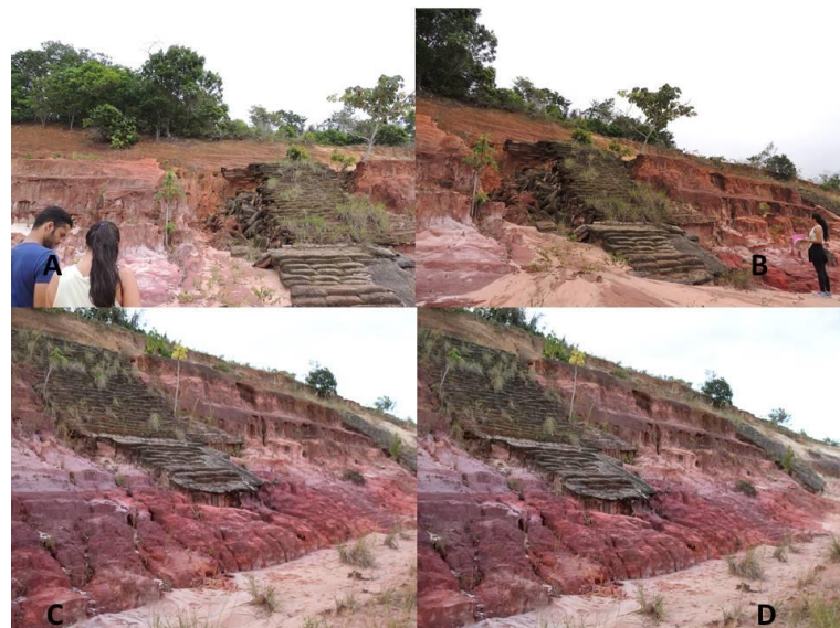
Figura 3: A, B- Contenção sacos solo cimento no ano de 2016. C, D- Contenção sacos solo cimento no ano de 2011. Fonte: Modificado do autor (2017).
