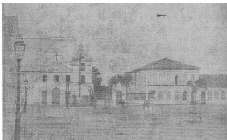
Figura 1: Propriedade do Coronel Felipe Pedreira de Cerrqueira.
