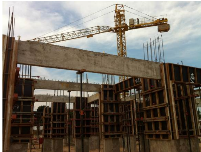
Figura 2: Imagem de uma montagem de uma viga. Fonte: Em construção-Casa nova. 2
