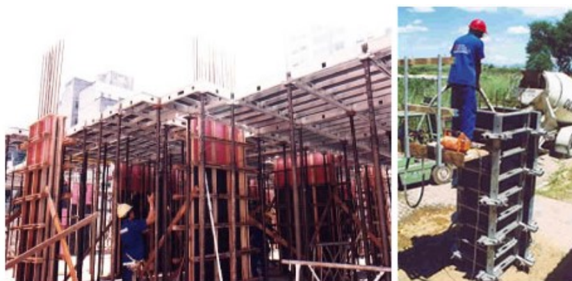
Figura 3: Pilar sendo concretado e detalhe da fôrma
