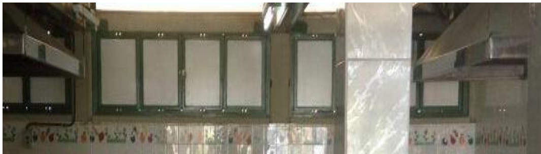
Figura 6: Janelas atuais da estrutura
