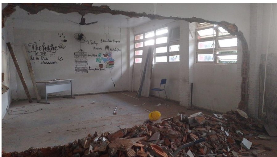
Figura 1: Sala de aula em reforma no pavilhão 2
