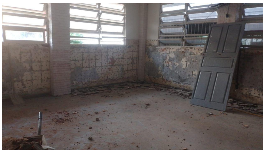
Figura 2: Outra sala de aula em reforma no pavilhão 2
