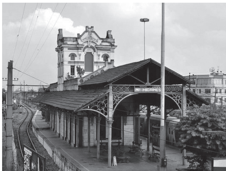
Figura 7: Estação Ferroviária de Marechal Hermes
