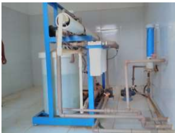
Figura 3. Unidade de dessalinização do povoado de São José- Umburanas. Operada por um líder local.
