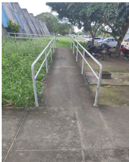
Figura 15 - Rampa - Saída do Módulo V
