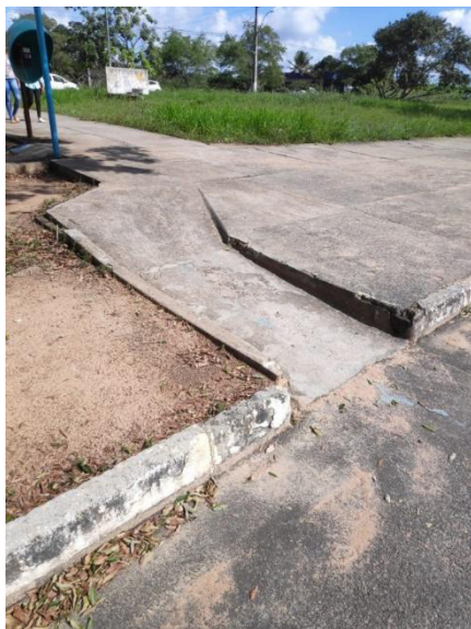
Figura 10 - Calçamento e rampa no Canteiro Central
