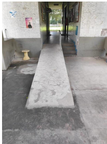
Figura 12 - Degraus e rampa na área do MA, módulo V
