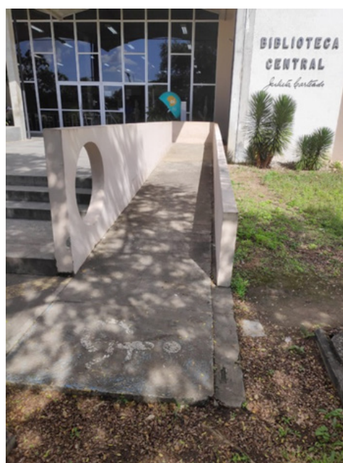
Figuras 17 e 18 - Rampa externa da Biblioteca
