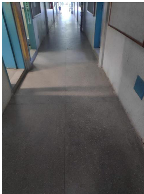
Figura 13 - Corredor dos Módulos teóricos
