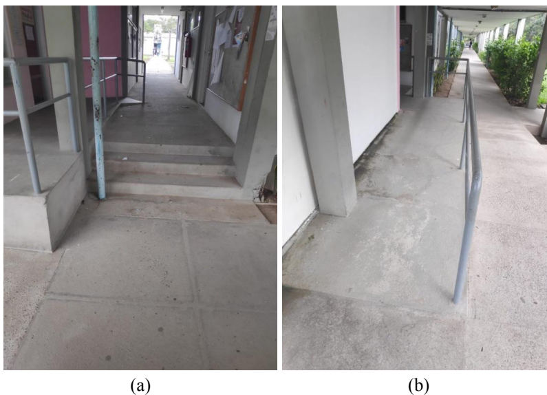
Figura 14 - Escada/Rampa no corredor dos MTs, Módulo IV
