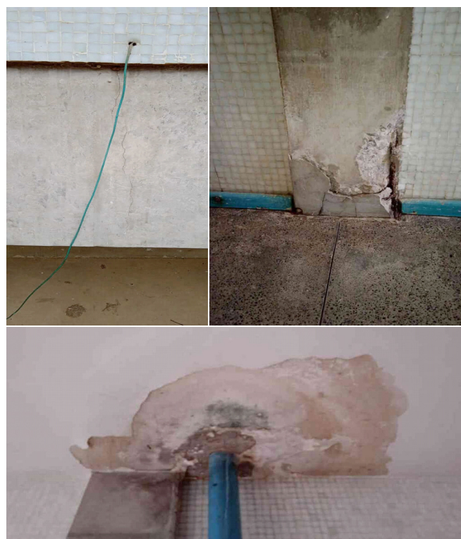
Figura 3 - Manifestações patológicas encontradas nos Módulos III, VI e V
