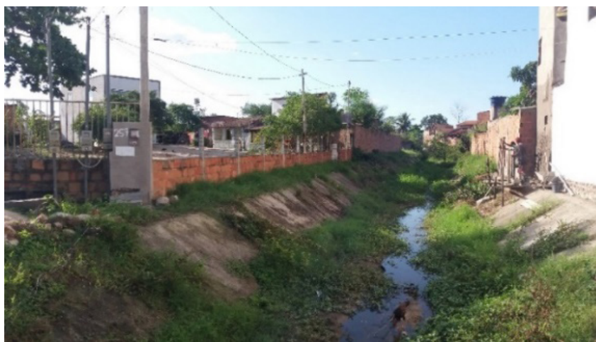
Figura 2 - Ocupações irregulares na APP do Rio Subaé em Feira de Santana/BA, 2021.
