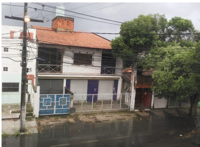
Figura 8 - Falta de escoamento na rua Dr. Sabino Silva, Feira de Santana-BA.
