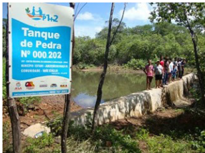
Figura 06. Tanque de Pedra
