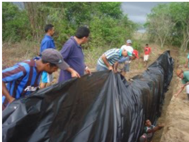
Figura 04. Construção da valeta da barragem subterrânea Fonte: ASA, 2014
