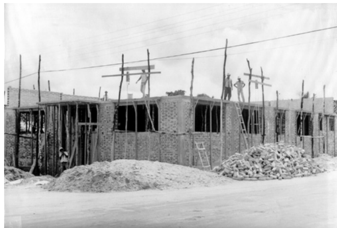
Figura 4. Construção da Prefeitura de Nova Canaã – década de 1960. (Foto: Arquivo pessoal de Ítalo Santana)
