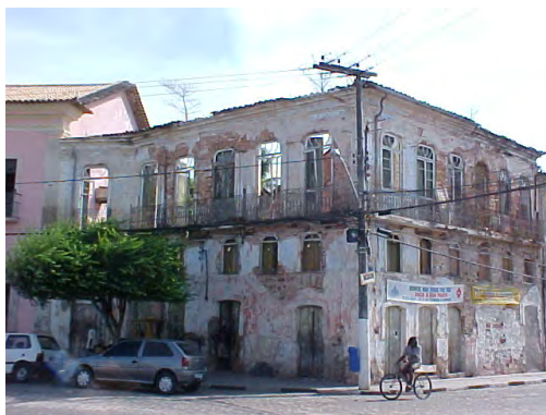
Figura 04: Ruínas do Imóvel na Praça da Aclamação, nº 02, antes da restauração
