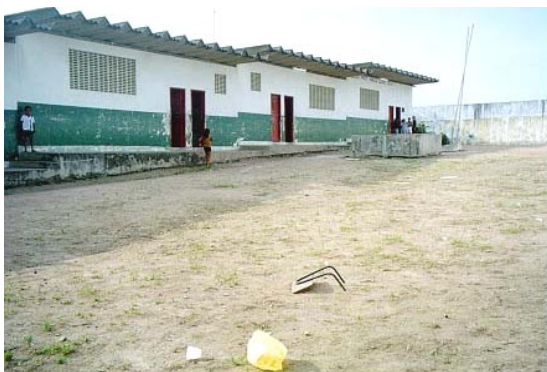
Figura 2 - Área interna da Escola
